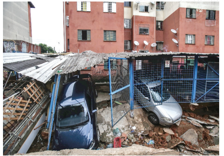
Fenda em condomínio tem 50 metros, segundo o Corpo de Bombeiros
