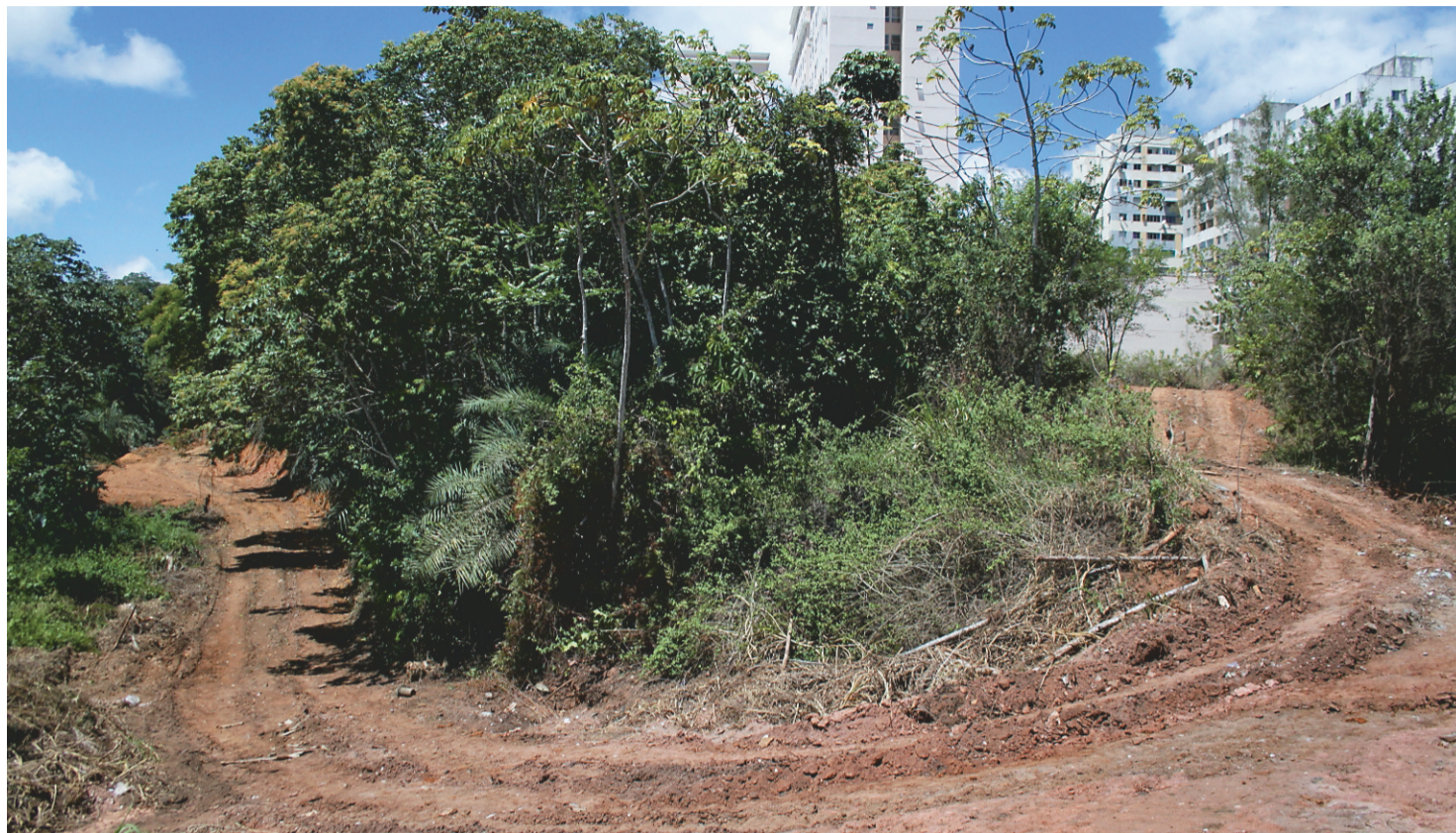
Área desmatada fica no fundo do condomínio Porto São Rafael; intervenção começou há uma semana, mas a obra está parada desde terça-feira
